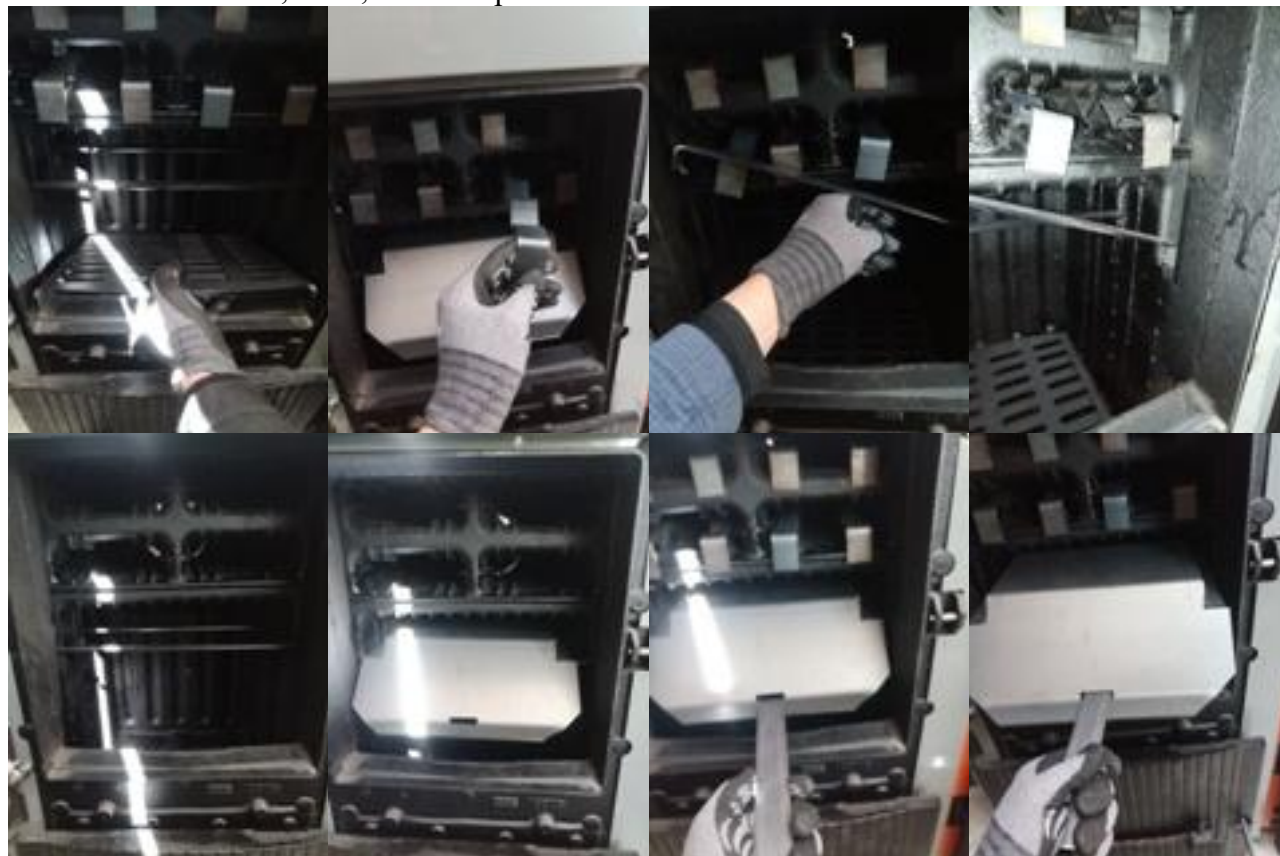
Instalace turbulátorů , roštu, dělicího plechu komoru.
