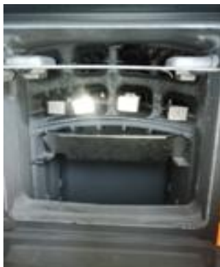
Turbulátory vložte do průduchů v horní části kotle
