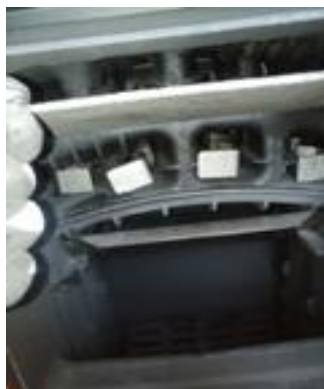
Turbulátory vložte do průduchů v horní části kotle
