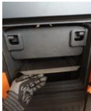
Nerezový plech zasuntě pod odvod spalin.
